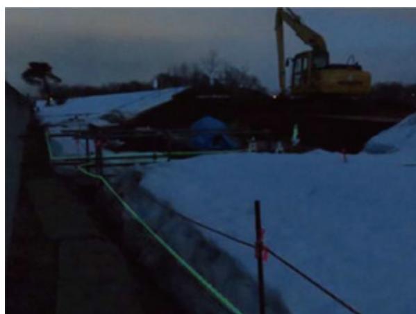
施工実例 工事現場
